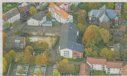
Hier findet man die Awo jetzt: Im Zentrum der Aufnahme, rechts neben der Kita, befindet sich das Gemeindezentrum.
